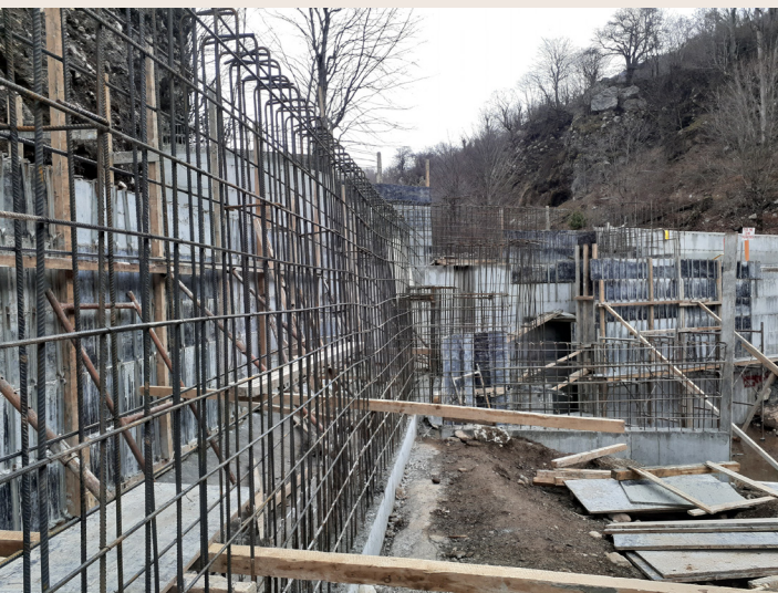
Diga e hidrocentralit që devijon rrjedhën e lumit, Zall Gjoçaj — Mat. Autor: Nebi Bardhoshi
